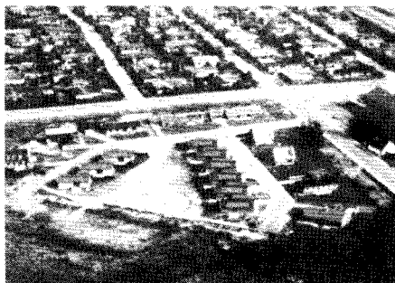
Im Vordergrund die Wohnanlage in Skive, Dänemark, wo unter der Schirmherrschaft der EG Energiesparhäuser gebaut und analysiert wurden.
