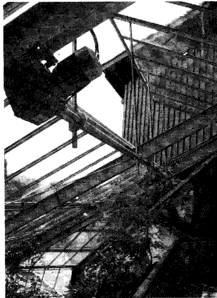
Große Lüftungsöffnungen sind unerlässlich für ein befriedigendes Gewächshausklima ohne Zug und Wärmestau.
