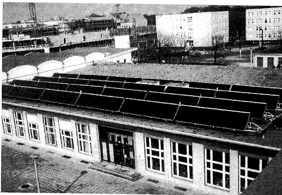
Abb. 1: Für die Öffentlichkeit sichtbarer Teil (180 m 2 ) der Solaranlage auf einem Zwischengebäude der Uni Magdeburg Fotos: Dr. Valentin
