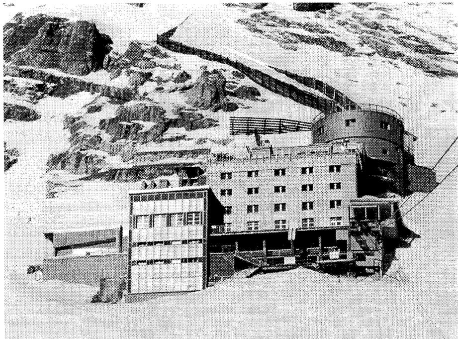
Abb. 1 und 2: Das Schneefernerhaus mit Kollektorfeld an der vorspringenden Südfassade. Je nach Lichteinfall wechselt die Farbe der Vakuum-Flachkollektoren von tiefschwarz bis silberm glänzend.
