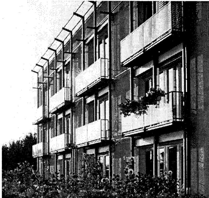
Abb. 3: Die Passivhäuser in Darmstadt-Kranichstein. Durch die Reihenhausbauweise werden die verlustbehafteten Oberflächen minimiert /9/.
