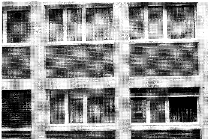
Abb. 7: Ansicht des Mehrfamilienhauses Wollerau/Schweiz – TWD-Module mit statischen Verschattungsblechen im Brüstungsbereich Foto: Ernst Schweizer AG
