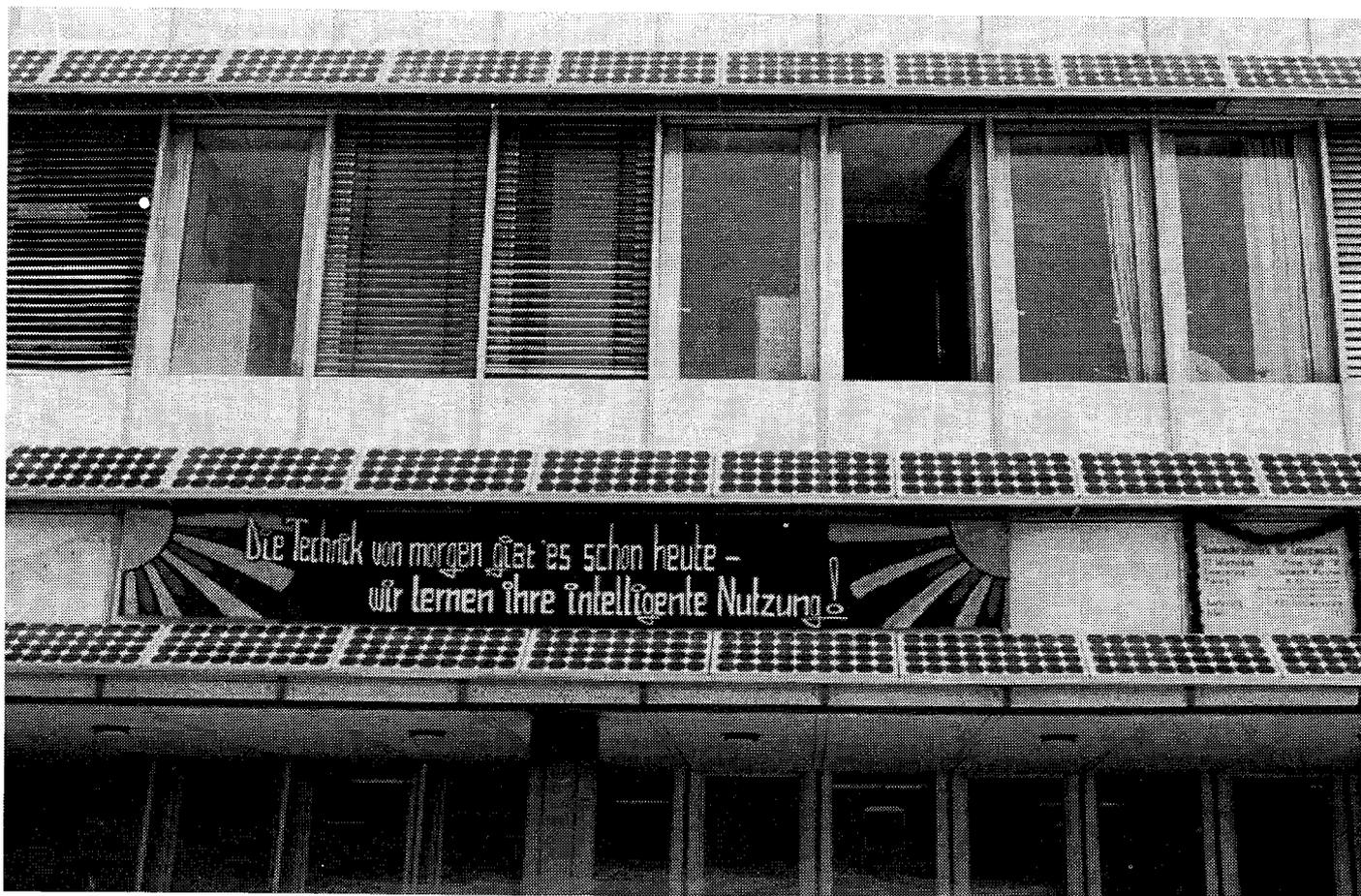
Abb. 1: Insgesamt 72 Solarmodule mit einer Gesamtleistung von 5,4 kW<sub>p</sub> sind in drei Reihen mit Winkeln von 35°, 45° und 55° an der Südfassade des Berufsbildungszentrums in München montiert.
