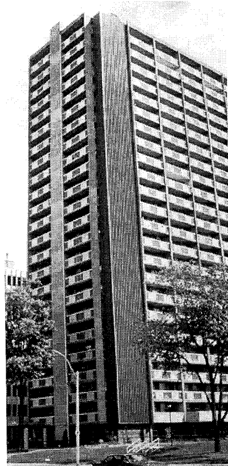
Abb. 4: 61 m hoher SOLARWALL Luftkollektor bei einer Betonfassadensanierung in Windsor, Ontario
