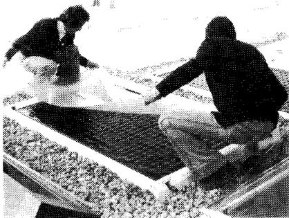
Bild 5: Ausnahmsweise werden die Kollektoren hier auf der Baustelle zusammengesetzt; der Stahlabsorber ist bereits eingelegt; soeben wird die Folie aufgespannt
