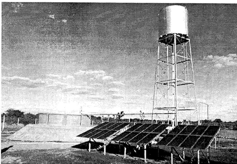
Abb. 2: Photovoltaisches Pumpsystem in El Quebracho, Argentinien mit 1,2 kW<sub>p</sub> PV-Leistung
