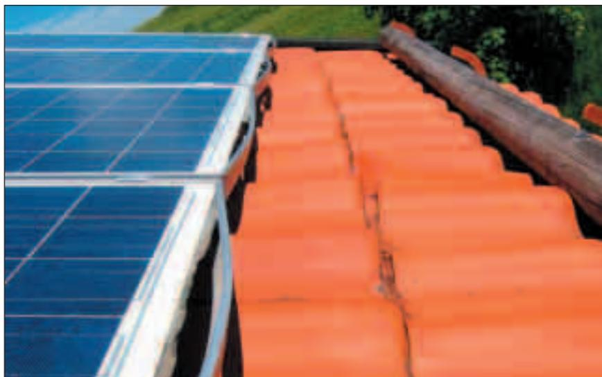
Schäden an Modulrahmen durch die Hangabtriebskraft von Schnee
